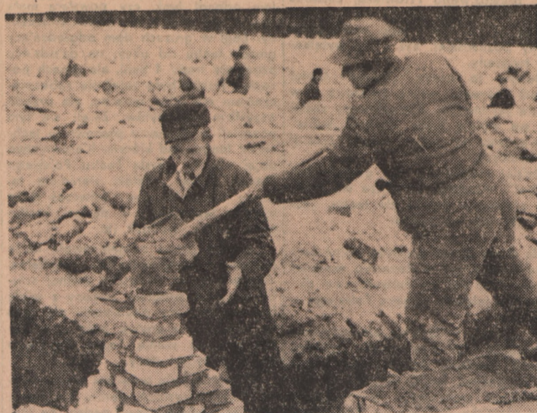
Murarz Brzeziński wraz z podręcznym muruje narożnik fundamentu, na którym oprze się Hotel Robotniczy. (Foto IKP)
