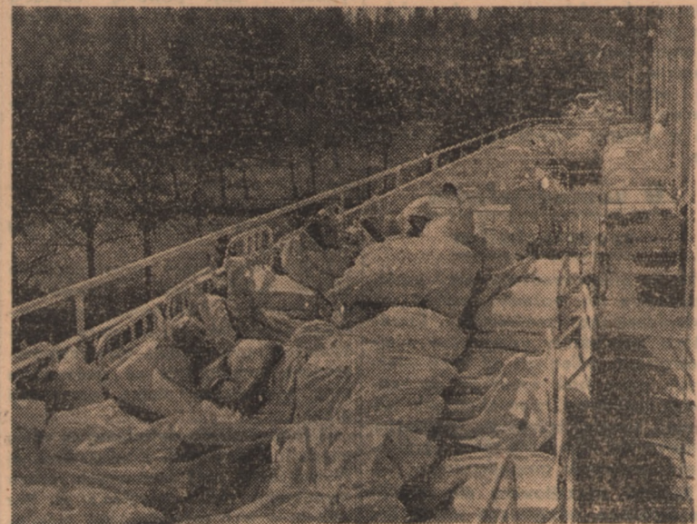
Największym wrogiem gruźlicy jest świeże powietrze. Chore dzieci przebywające w Sanatorium Gruźliczym w Kamiennej Górze wykorzystują pogodną chwilę na odpoczynek na tarasie. (Archiwum IKP)
