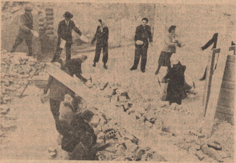
Członkowie Związku Zawodowego Pracowników Finansowych w Bydgoszczy z zapalem pracują przy budowie nowego zakładu pracy. Jest to ich czyn ku czci Święta Pracy. (Foto IKP)
