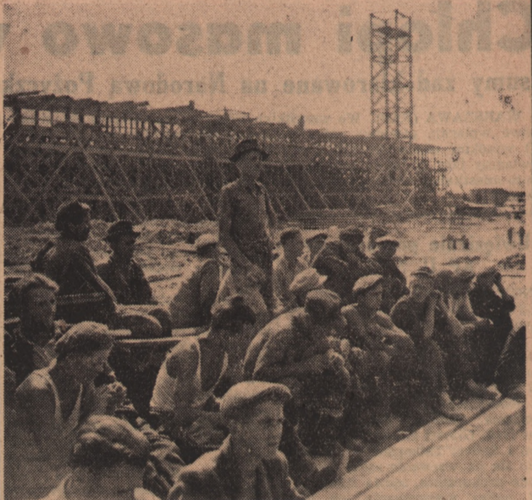
Jedną z budowli Planu 6-letniego jest powstająca w Lublinie fabryka samochodów ciężarowych. Odpowiadając na apel huty „Kościuszko” żaloga, zatrudniona przy budowie jednej z hal, podjęła zobowiązanie zespołowe postanawiając oddać ją do użytku na 45 dni przed terminem, przewidzianym w planie robót. Na zdjęciu fragment z masówki, na której podjęto zobowiązanie. (Foto — CAF)
