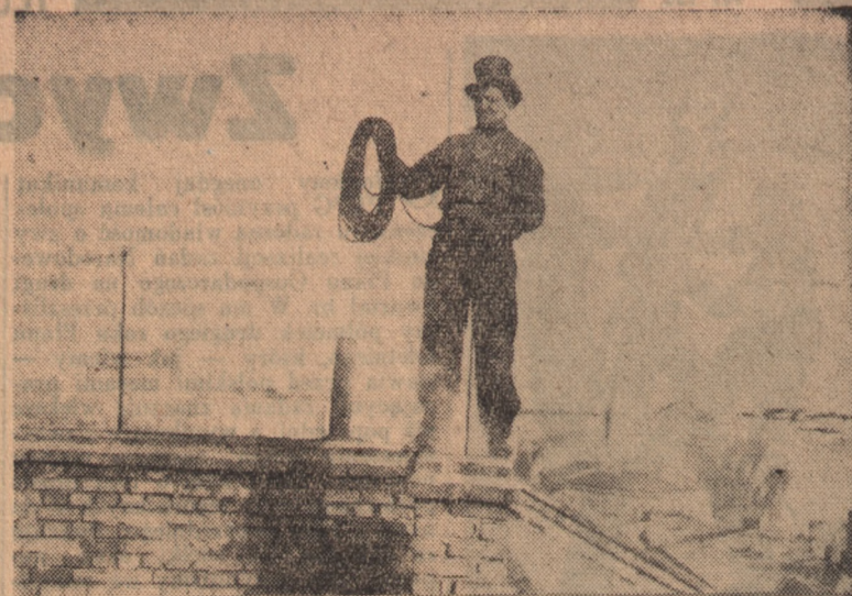
Kominiarz z poznańskiej spółdzielni przy pracy (Patrz artykuł niżej)
