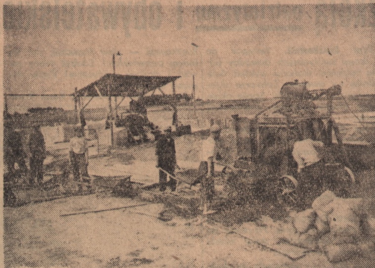
Jedną z wielkich inwestycji Planu 6-letniego jest budująca się wielka cementownia „Rejowiec 2”. Na zdjęciu: Przygotowanie betonu do budowy ław fundamentowych (Foto — CAF).
