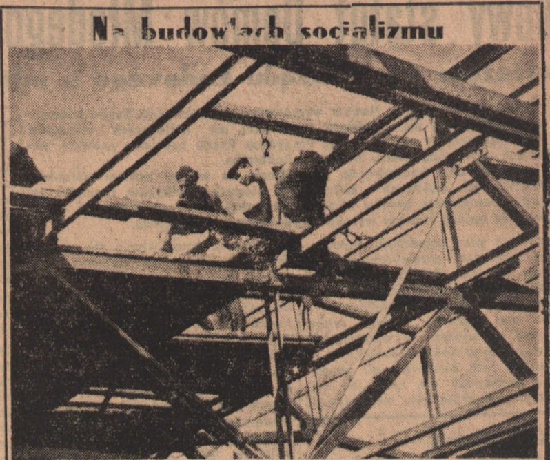
Jak już donosiliśmy na terenie huty „1 Maja” w Gliwicach budowana jest obecnie nowa prasownia, która rozpocznie prace już w 1952 roku. Prasownia zaopatrzona zostanie w najnowocześniejsze urządzenia i będzie całkowicie zautomatyzowana.
