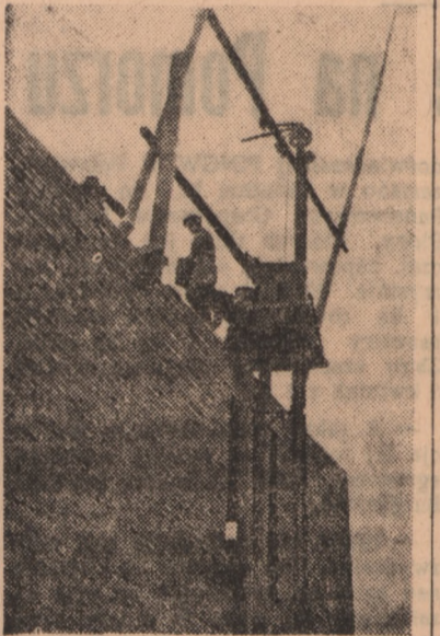
Pomiędzy stropem a niebem.
