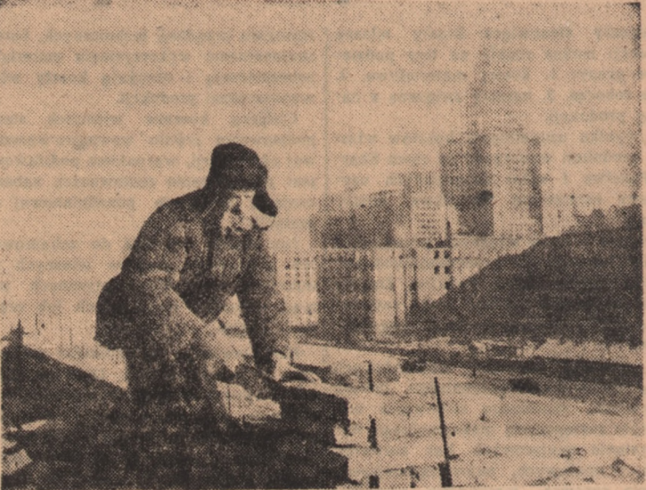
Wieżowiec Uniwersytetu Moskiewskiego w budowie. Murarz Masalov przy ścianie laboratorium.
