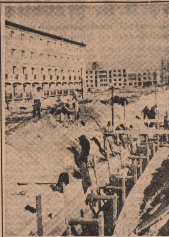
Budowa osiedla C-I w Nowej Hucie
