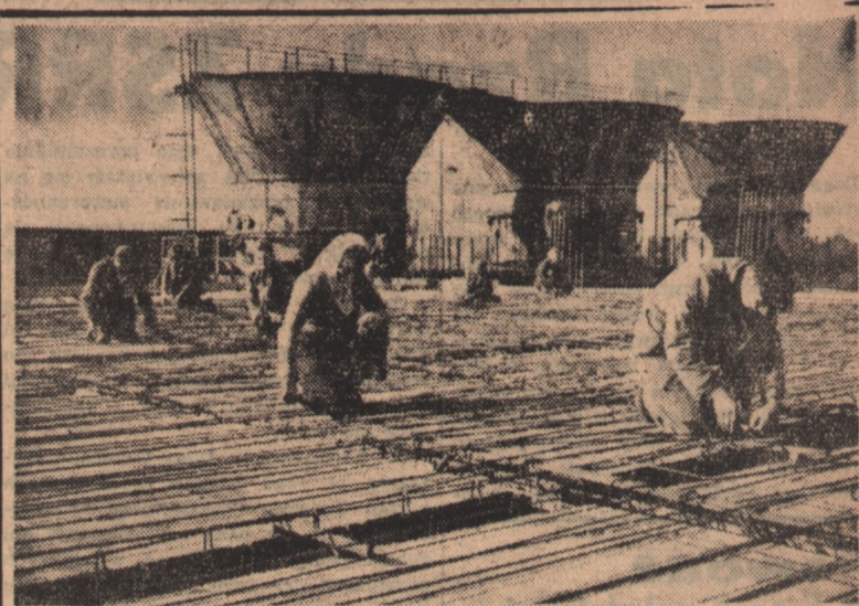
Rozbudowa Wrocławskich Zakładów Włókien Sztucznych postępuje szybko naprzód. Na zdjęciu: Pracująca brygada zbrojarzy Eugeniausza Podłęskiego pracuje przy zbiorzeniu stropów nowej hali. Brygada osiąga 175 proc. normy. Foto — CAF
