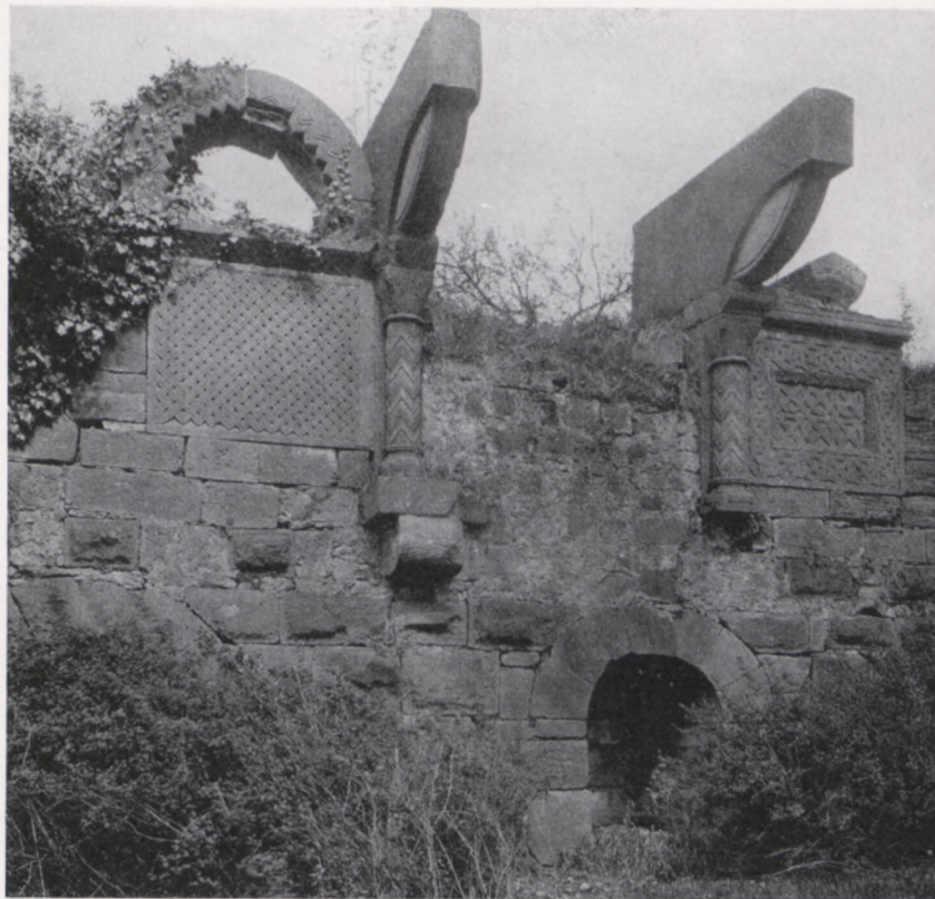
30. Reste des Kamins aus dem Palasaal der Kaiserpfalz Gelnhausen. Man beachte besonders die reich ornamentierten Steinplatten rechts und links.
