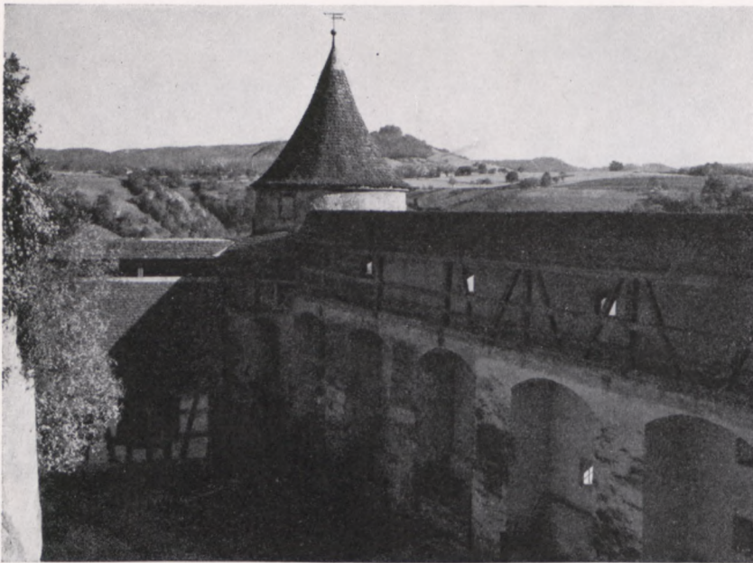
27. Teil der Burgmauer des Schlosses Kumburg mit Wartturm.
