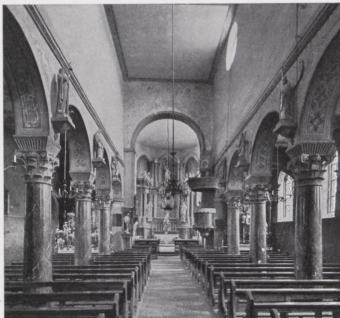
5. Inneres der Justinuskirche in Höchst. Eine der wenigen noch heute im Aufbau erhaltenen karolingischen Kirchen. Besonders die kurzen, gedrungenen Säulen zeigen die nordische Eigenart gegenüber der Antike. (Phot. Staatl. Bildstelle, Berlin.)
