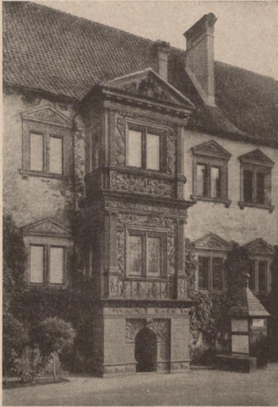
302. Heldburg, Französ. Bau.
