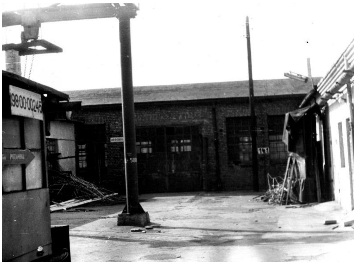
Ośrodek Obliczeniowy w Grudziądzu. Prace adaptacyjne. Fot. ze zbiorów Autora.
