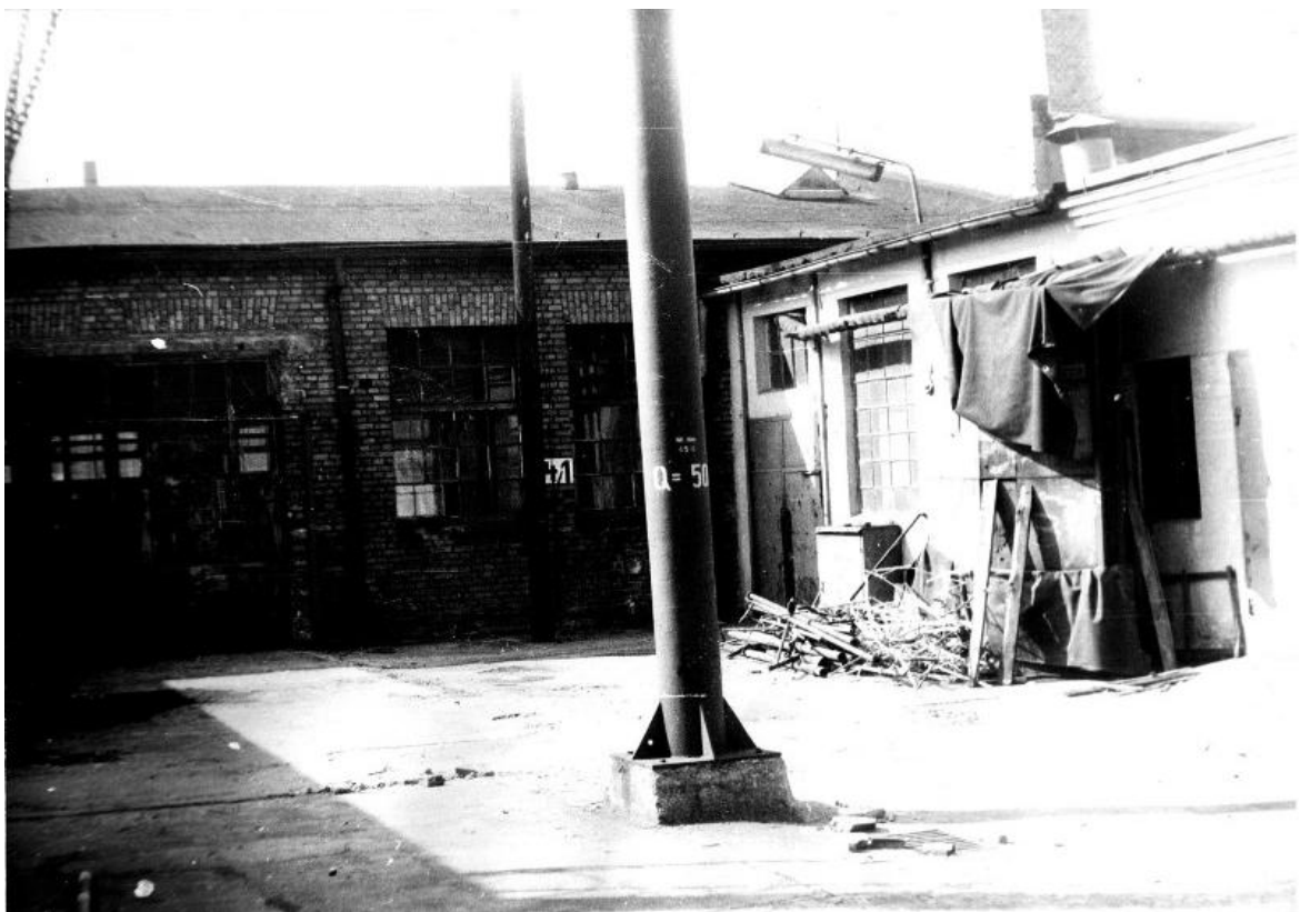
Prace adaptacyjne w Ośrodku Obliczeniowym przy ul. Staszica w Grudziądzu. Fot. ze zbiorów Autora.
