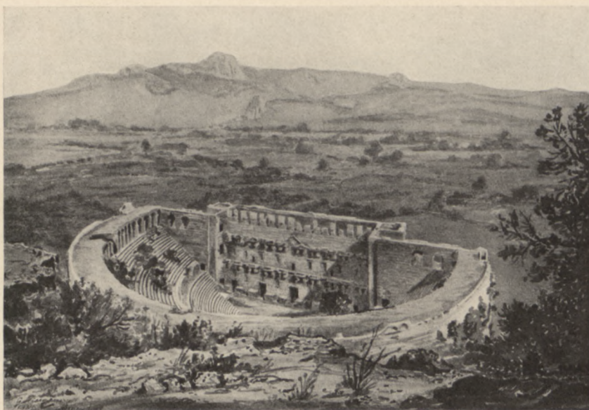
97. Theater von Aspendos, Blick von oben ins Innere auf das Bühnenhaus mit der Scenae-frons. Wiederherstellung G. Niemann.
