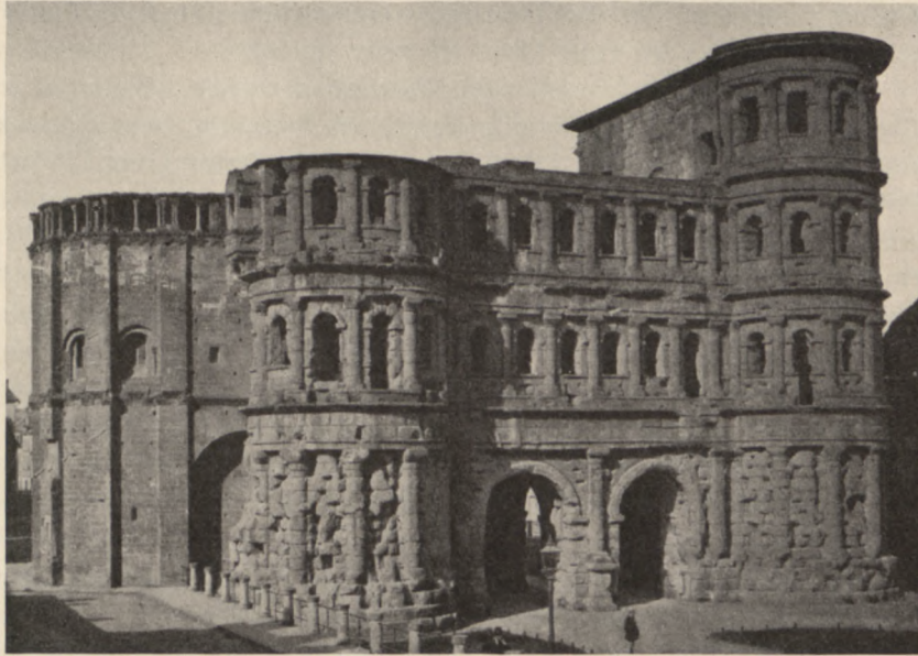
104. Die Porta Nigra, Trier; Feldseite, links die Apsis der im Mittelalter eingebauten, jetzt wieder abgebrochenen Kirche.
