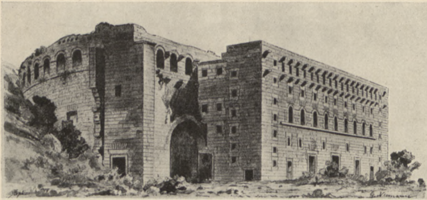
98. Theater von Aspendos. Blick von außen auf die Front des Bühnenhauses und den Ansatz der Schaurund-Außenmauer. Wiederherstellung G. Niemann.
