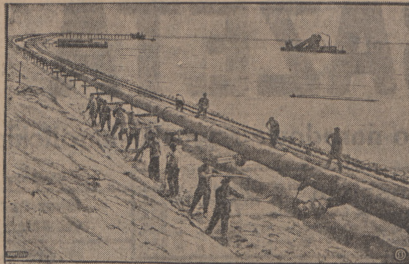
Budowa przesmyku, łączącego wyspę Sylt z lądem stałym długości 11 klm. ma się już ku końcowi. Od fal jest przesmyk zabezpieczony 2-metrowym wałem. Zdjęcie nasze przedstawia budowę przesmyku.
