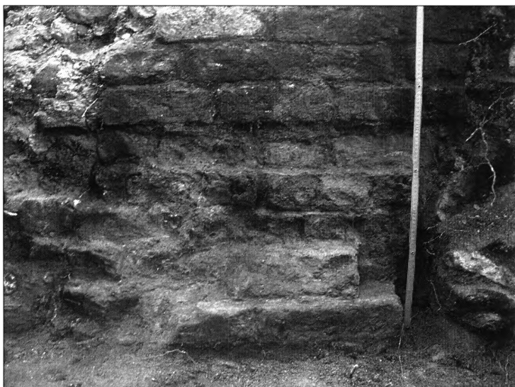
Il. 10. Toruń, Fosa Staromiejska 10. Wykop pod kanalizację ogólnospławną (odcinek S1–S2). Zewnętrzne, północne lico muru baszty z odsadzką. Fot. D. Poliński
