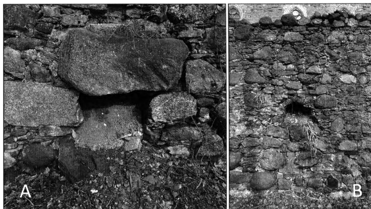
Il. 10. Zamek Bierzgłowski (dawne Bierzgłowo). Wyloty kanałów w południowym murze parchamu. A – zachodni, B – wschodni
