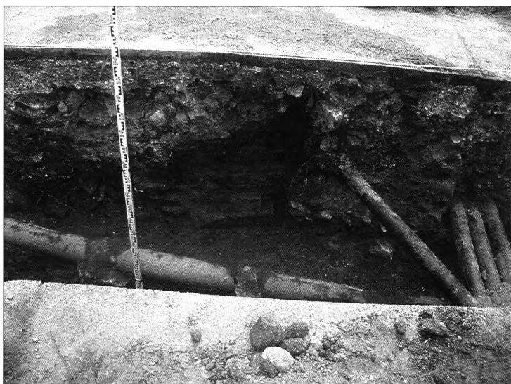
Il. 9. Toruń, Fosa Staromiejska 10. Wykop pod kanalizację ogólnospławną (odcinek S1–S2). Pozostałości architektury murowanej, w tym zewnętrzne, północne lico muru baszty z odsadzką. Fot. D. Poliński
