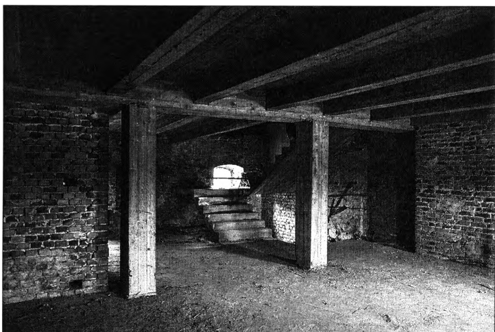
Il. 10–12. Wnętrza spichlerzy przy ul. Spichrzowej 33 i 35 przed adaptacją, stan na dzień 4.08.2020 r. Fotografie ze zbiorów MKZ w Grudziądzu
