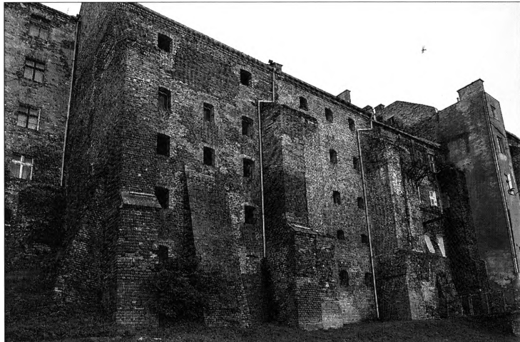
Il. 9. Elewacja zachodnia spichlerzy przy ul. Spichrzowej 33 i 35 przed adaptacją, stan na dzień 4.08.2020 r. Fotografie ze zbiorów MKZ w Grudziądzu
