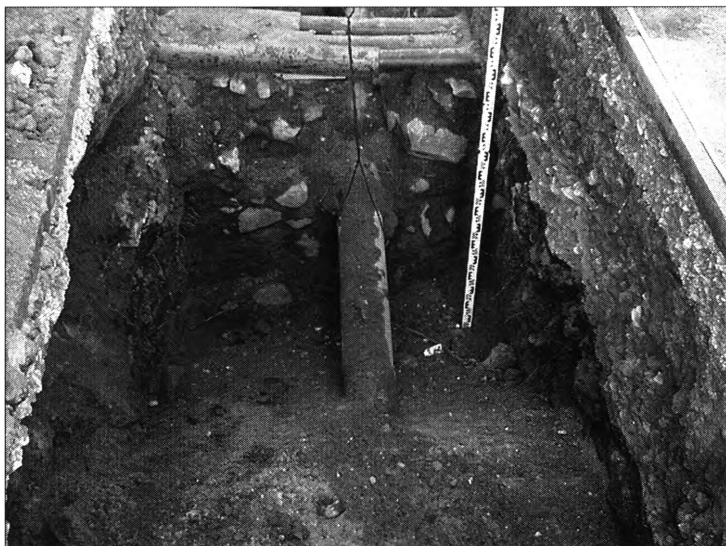
Il. 7. Toruń, Fosa Staromiejska 10. Wykop pod kanalizacją ogólnospławną (odcinek S1–S2). Kamienny fundament muru miejskiego (profil zachodni). Fot. D. Poliński
