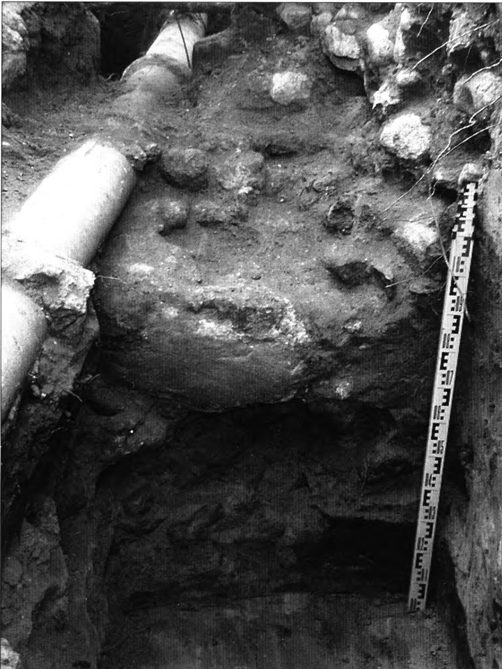
Il. 6. Toruń, Fosa Staromiejska 10. Wykop pod kanalizację ogólnospławną (odcinek S1–S2). Kamienny fundament muru miejskiego (profil wschodni). Fot. D. Poliński
