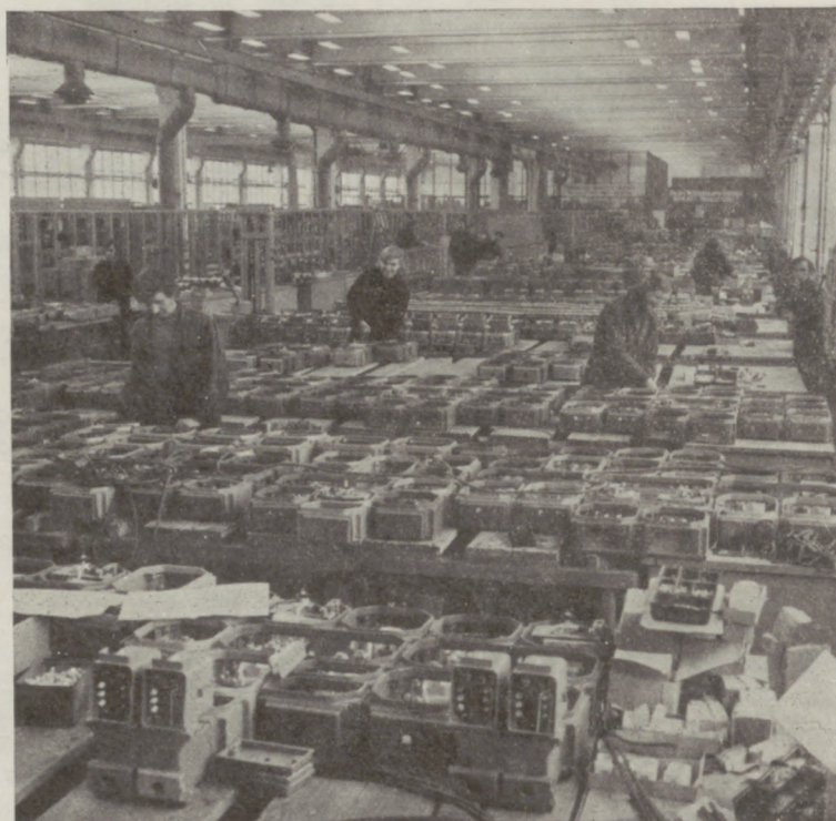
Montaż rozdzielnic okapturzonych
