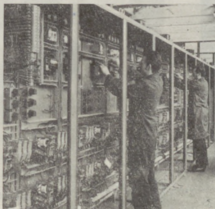
Montaż rozdzielnic szkieletowych
