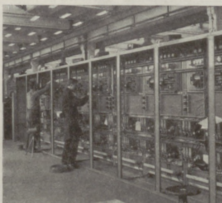
Montaż urządzeń rozdzielczo-sterowniczych
