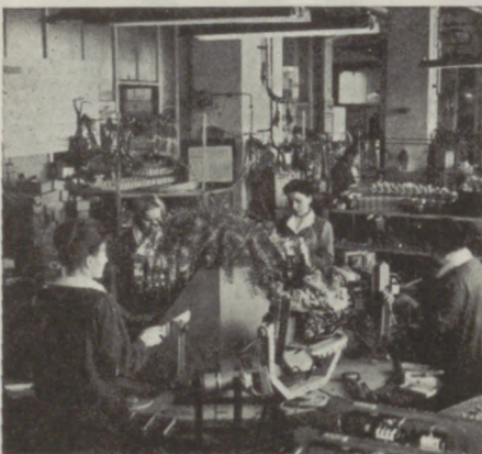
Montaż zespołów wysuwalnych aparatury przeciwwybuchowej
