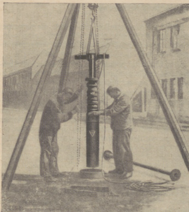
Rys. 5. Opuszczanie agregatu do studni
