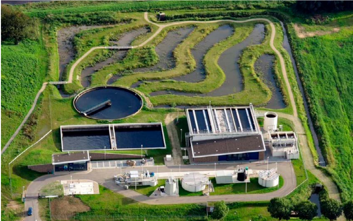
Rysunek 5-7. Widok na oczyszczalnię ścieków w miejscowości Dinxperlo (Holandia) [royalhaskoningdhv.com]
