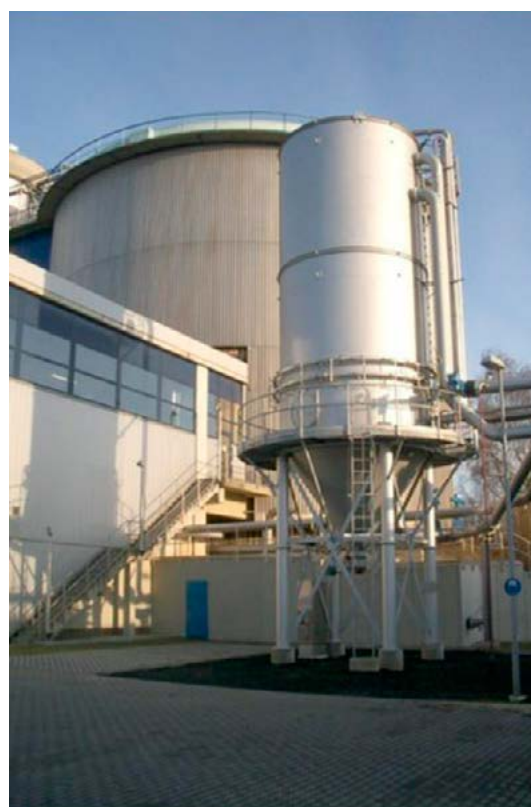
Rysunek 4-12. Reaktor do odzysku fosforu w oczyszczalni ścieków w Mönchengladbach (Niemcy) [Langereis i in. 2015]
