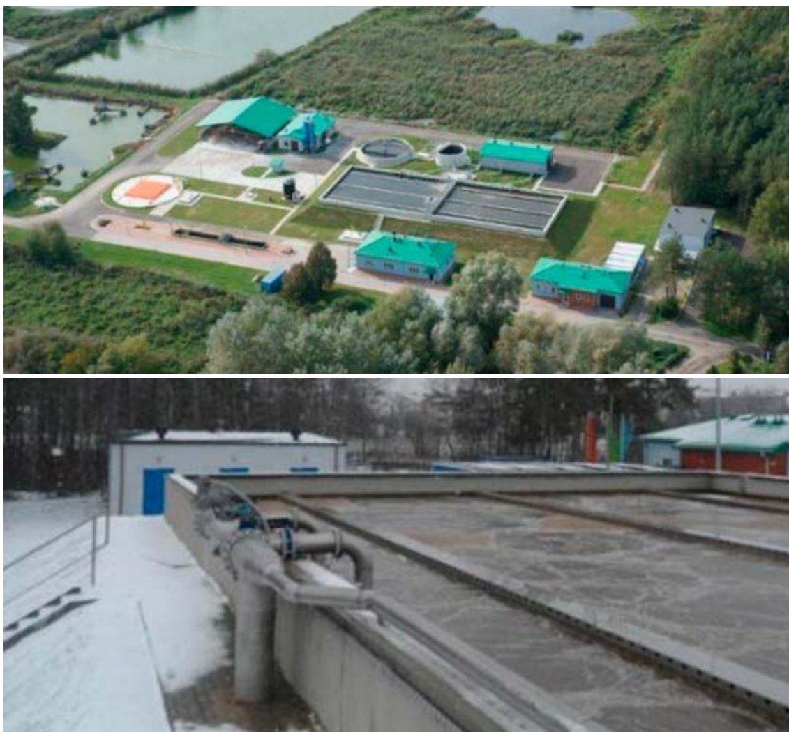
Rysunek 5-4. Widok na oczyszczalnię ścieków „Fregata” w Rykach oraz reaktor biologiczny pracujący w technologii Nereda [royalhaskoningdhv.com]
