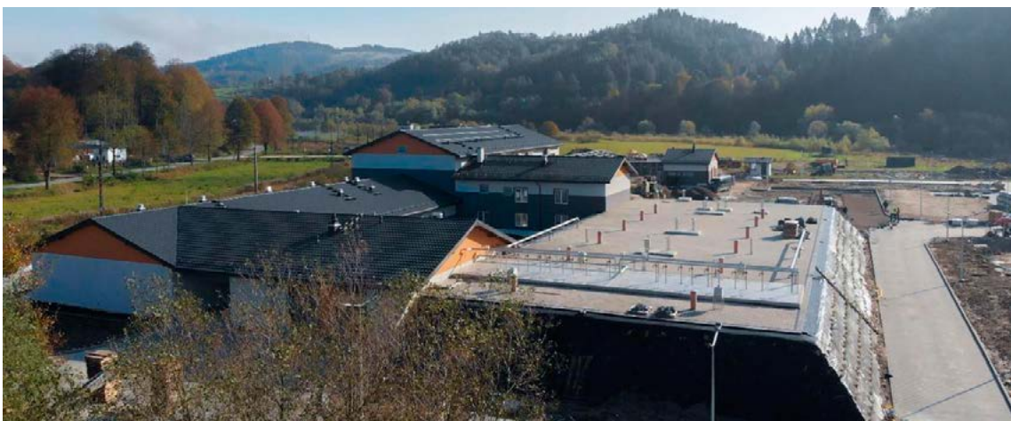
Rysunek 6-5. Widok na oczyszczalnię ścieków w miejscowości Muszyna (Polska) [schwander.pl]
