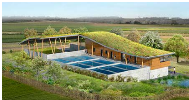
Rysunek 5-5. Widok na oczyszczalnię ścieków w miejscowości Fleury (Francja) [royalhaskoningdhv.com]
