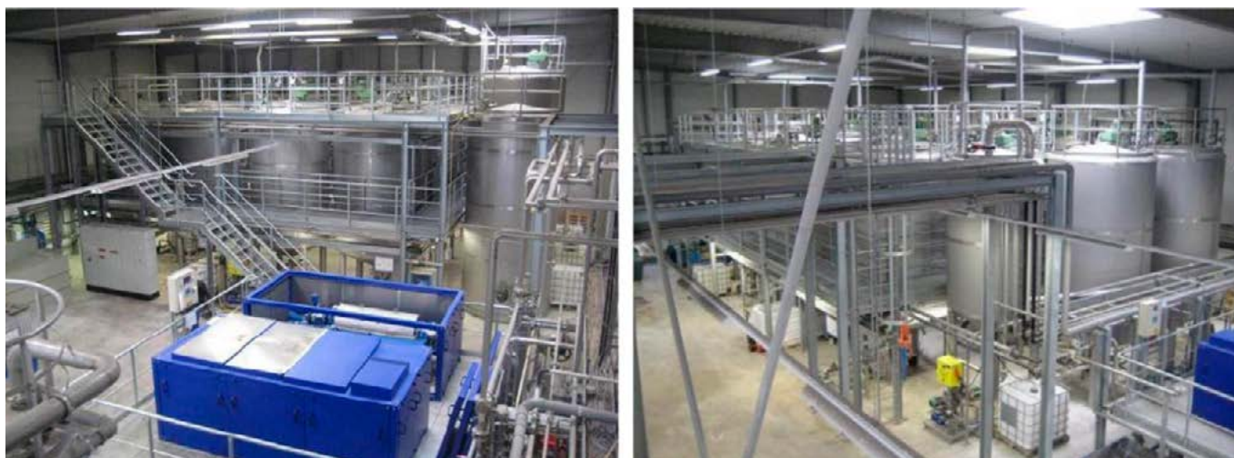
Rysunek 4-13. Instalacja do odzysku fosforu w oczyszczalni ścieków w Gifhorn (Niemcy) [Nieminen 2010, Müller 2011]
