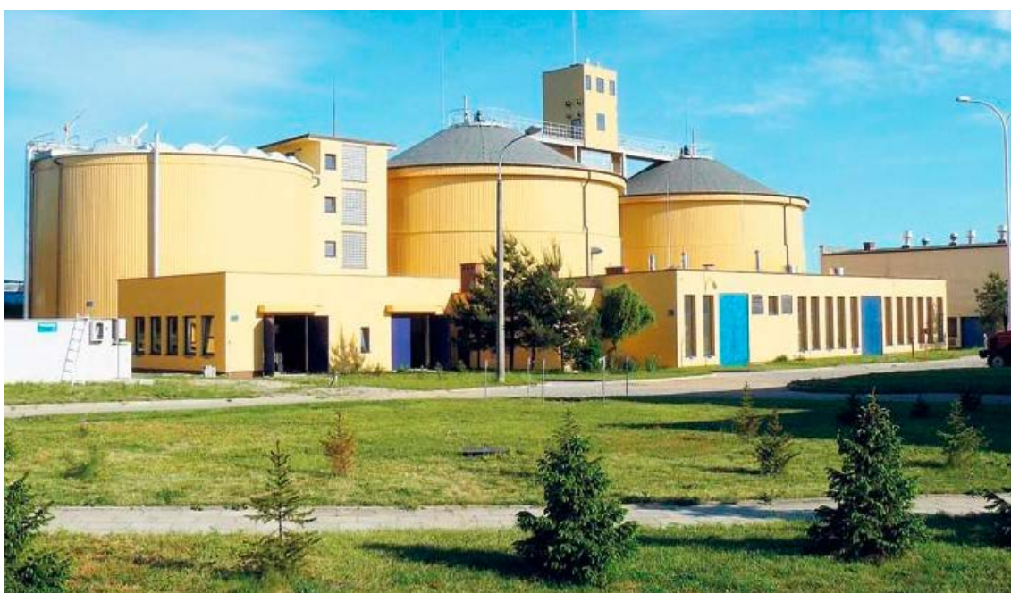
Rysunek 9-4. Biogazownia funkcjonująca w oczyszczalni ścieków w Tychach [egospodarka.pl]
