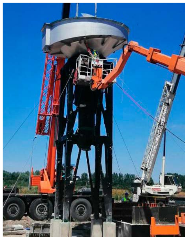
Rysunek 4-9. Instalacja reaktora do odzysku fosforu w oczyszczalni ścieków w Cielczy (Polska) [pwikjarocin.pl]
