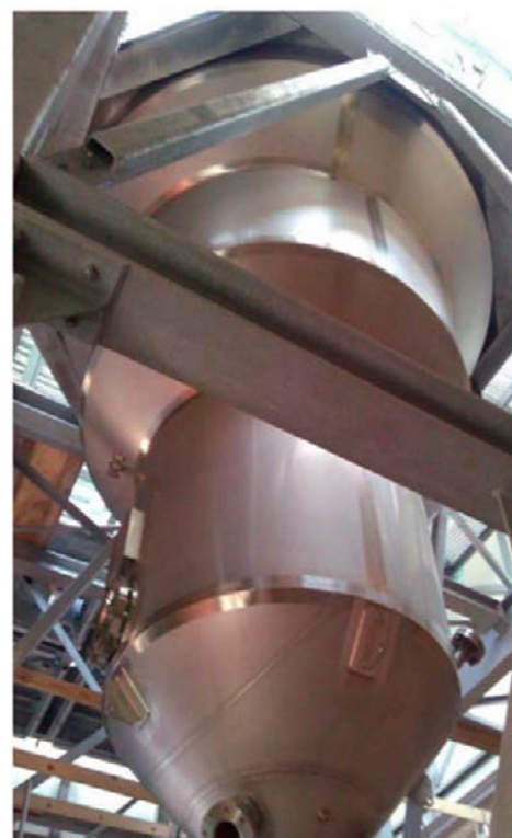
Rysunek 4-10. Reaktor do odzysku fosforu w oczyszczalni ścieków w Amersfoort (Holandia) [Kox i in. 2016]
