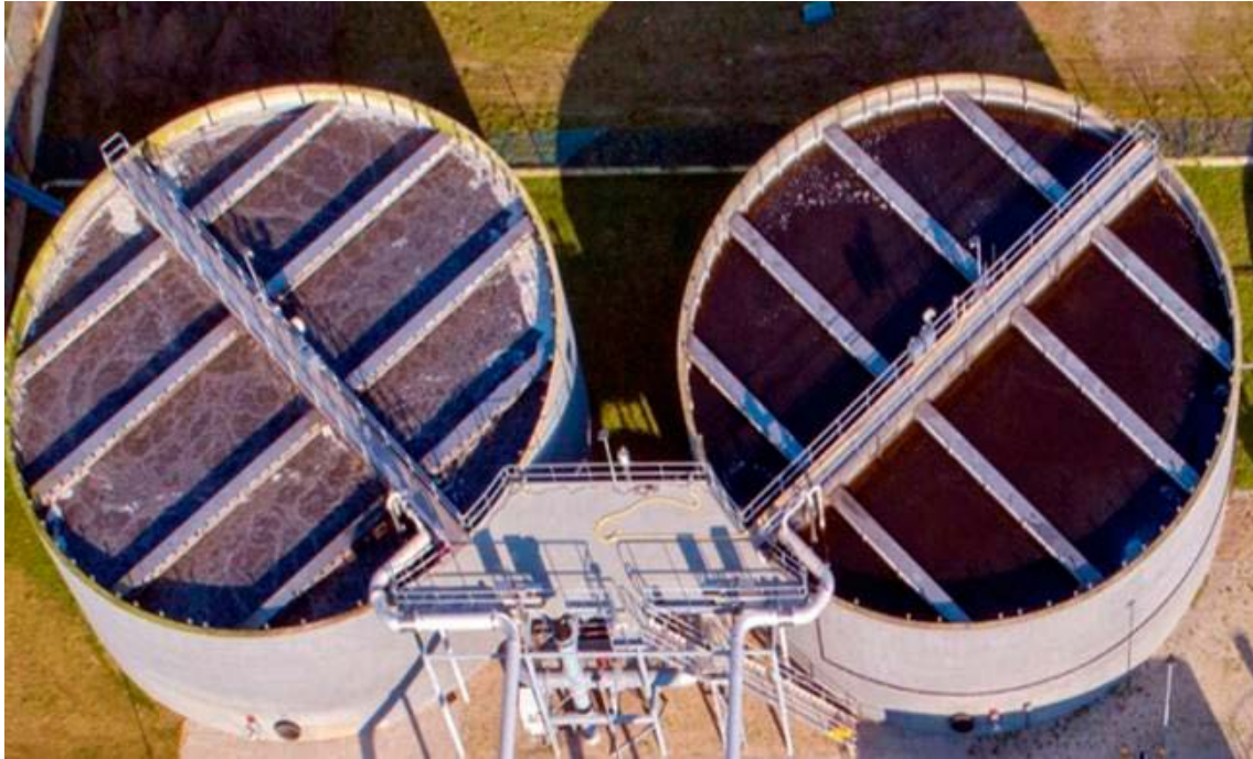
Rysunek 8-8. Reaktory Nereda w oczyszczalni ścieków w Zutphen (Holandia) [Lavender i in. 2021]
