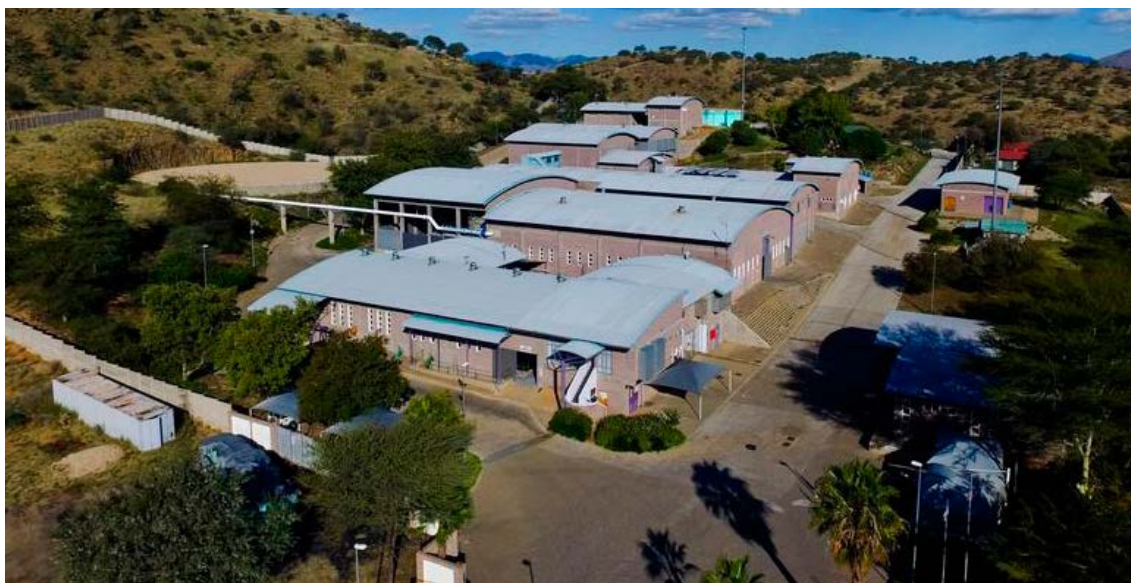
Rysunek 9-7. Zakład odnowy wody ze ścieków miejskich w Windhoek (Namibia) [wingoc.com.na]
