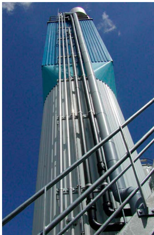
Rysunek 7-13. Reaktor Anammox w oczyszczalni ścieków w Rotterdamie (Holandia) [Van der Star i in. 2007]
