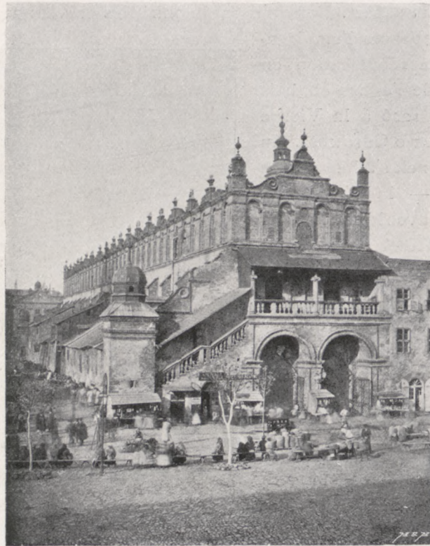
Les Sukiennice avant la restauration.
