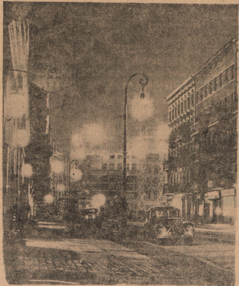
Berlin w nocy. W głębi oświetlona reflektorami budowa nowego gmachu mieszkaniowego przy Weberwiese.
