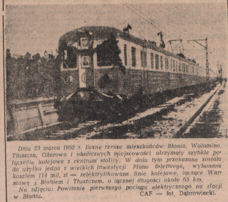
Dnia 23 marca 1952 r. liczne rzesze mieszkańców Błonia, Wołomina, Tuszcza, Ożarowa i okolicznych miejscowości otrzymały szybkie połączenie kolejowe z centrum stolicy. W dniu tym przekazana została do użytku jedna z wielkich inwestycji Planu 6-letniego, wykonana kosztem 114 mil. zł — zelektryfikowane linie kolejowe, łączące Warszawę z Błoniem i Tuszczem, o łącznej długości około 65 km. Na zdjęciu: Powitanie pierwszego pociągu elektrycznego na stacji w Błoniu. CAF — fot. Dąbrowiecki.
