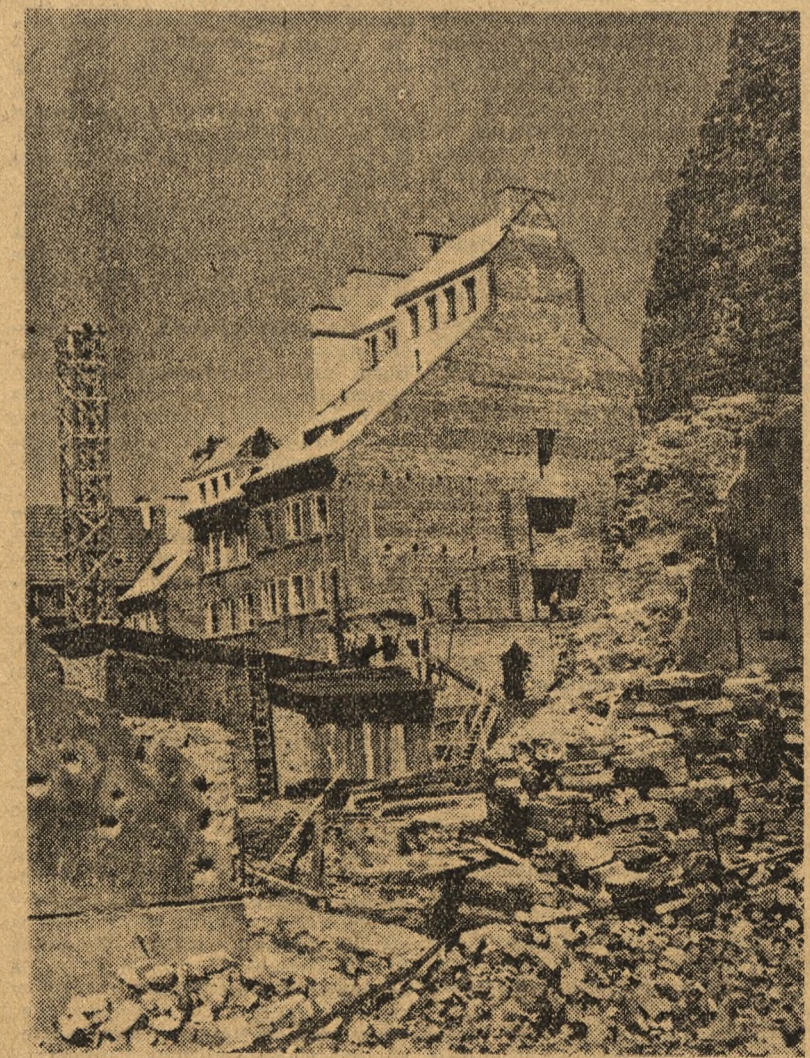
W dalszym ciągu trwają prace przy odbudowie i rekonstrukcji zabytkowych kamieniczek Starego Miasta w Warszawie. Kamieniczki te, odbudowane według starych wzorów, zostaną w niedługim czasie oddane do użytku. NA ZDJĘCIU: Fragment odbudowy kamieniczek przy ul. Piwnej.
