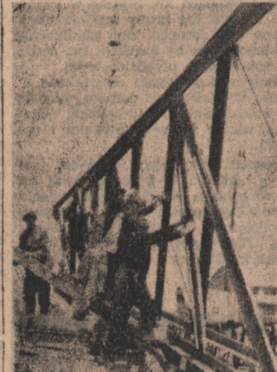
Na zdjęciu: Przdająca brygada montażowa Jana Mastaja montuje więzania hali głównej. (Foto — CAF)
