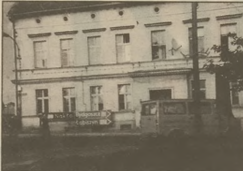
Budynek przy ul. Kościuszki z wybitymi szybami.
