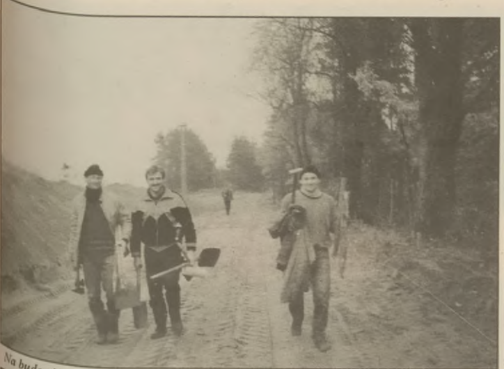
Na budowie drogi
