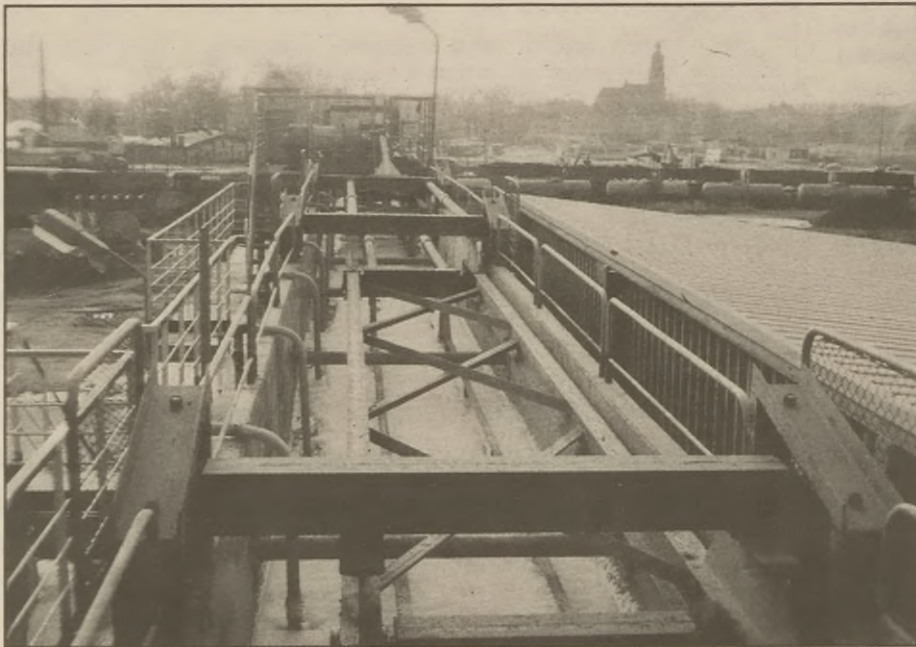
Oczyszczalnia mechaniczna wód splawikowych - łapacz piasku
