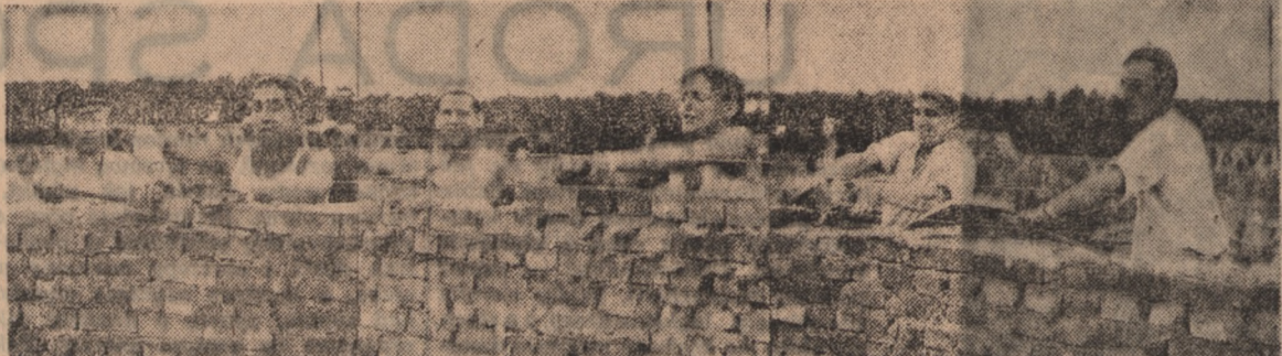
W dniu 18 bm. szóstką murarską w składzie: kpr. Bernard Reimer, st. szer. Karol Wolszon, szer. Sylwester Kaszuba, kpr. Zdzisław Lewicki, szer. Jan Marcinkowski i kpr. Guignon Kowalski, pracująca przy budowie, prowadzonej przez oddział WPB w Bydgoszczy, ustanowiła rekord Polski układając w ciągu dnia pracy 94.988 sztuk cegieł. Na zdjęciu szóstka rekordzistów. (Foto — IKP)
