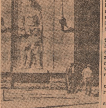
Nauczycielka — płaskorzeźba na elewacji gmachu 6-A.
