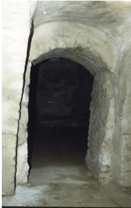
Fot. 3. Piwnica kamienicy przy ul. Klasztornej 6. Portal północny d. kaplicy św. Michała Archanioła, z lat 20 XIII w. Stan w 1998 r.
