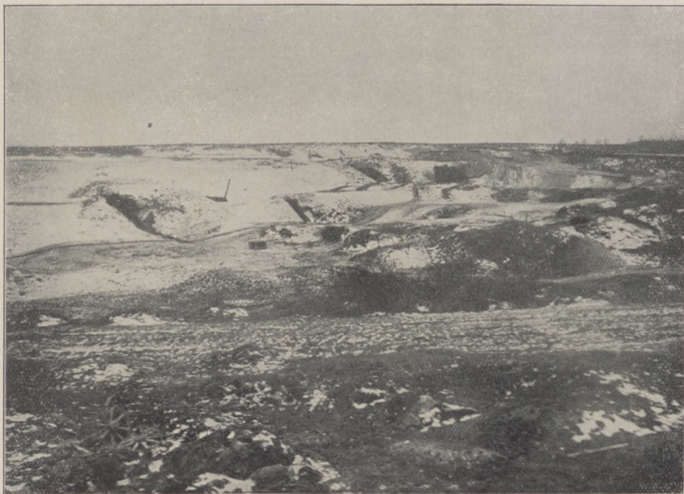
Erdwohnungen vor Reims
