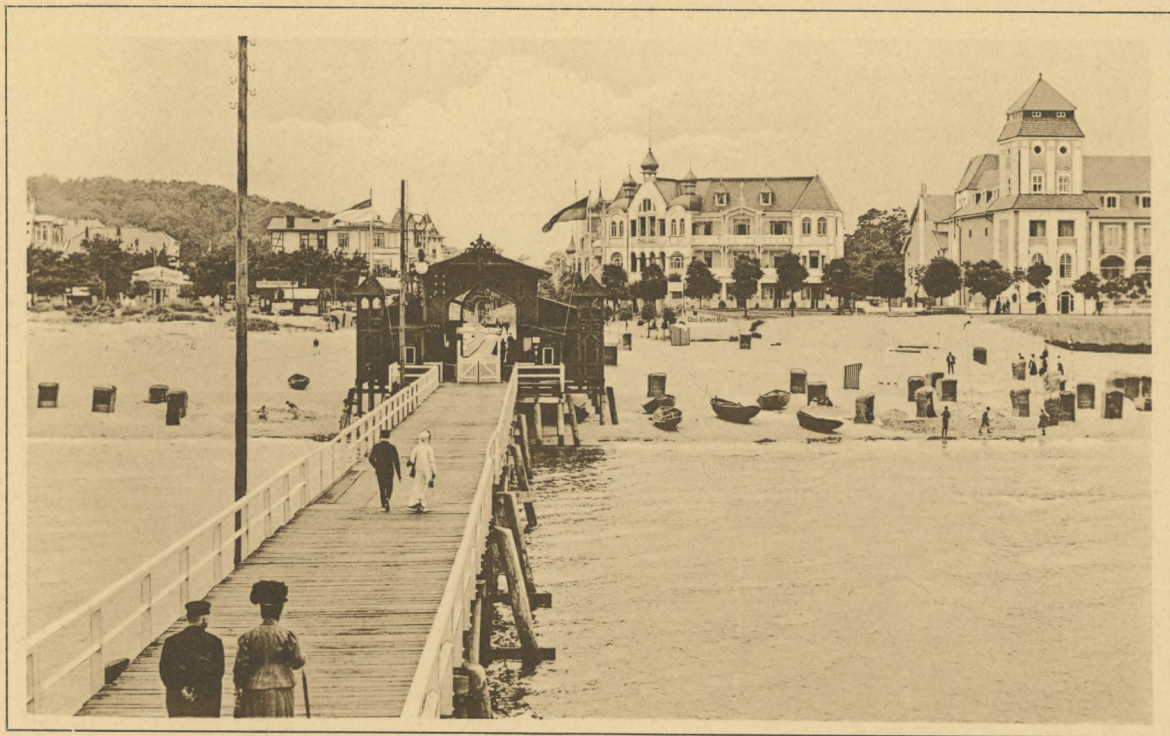
Binz. Strand mit Kurhaus von der Brücke aus.
