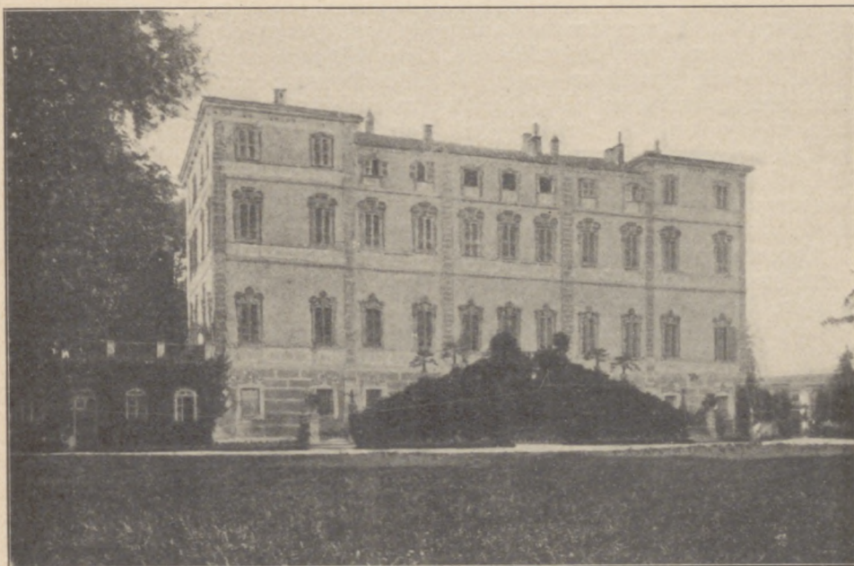
Abb. 59 · Santena · Castello Cavour · Fassade nach dem Park
