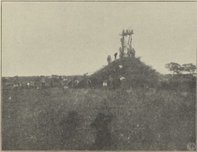
Bau des Signalturms von Otjosondufu
