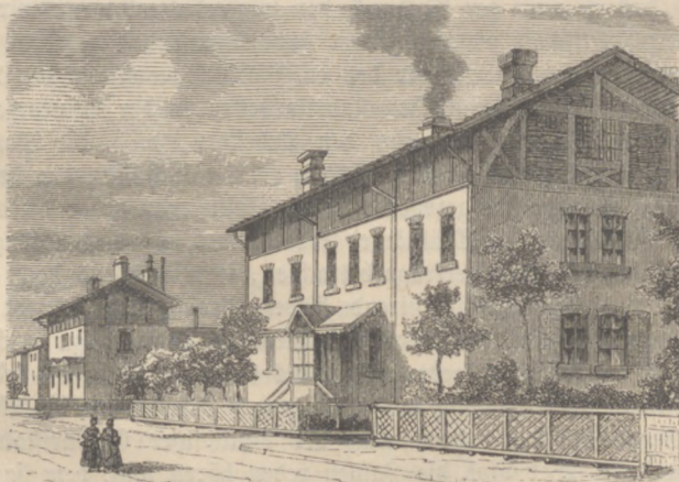
Bäckerei, Waschanstalt, Speisehaus und Bad in Mülhausen.
