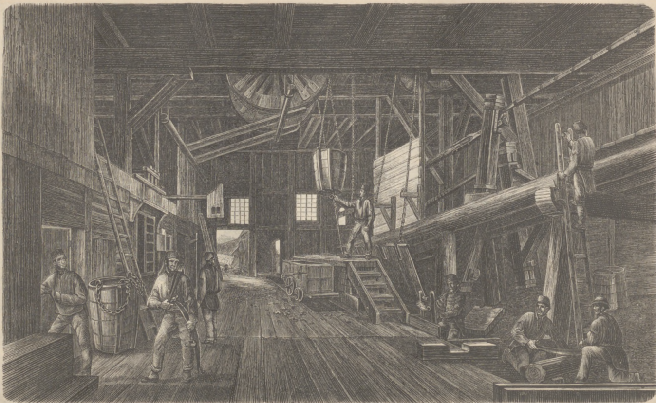
In einem Bechenhause bei Klausthal.
