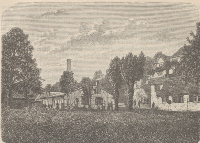
Grenzhammer bei Ilmenau.
