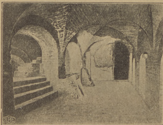
5. Schody prowadzące do kaplicy greckiej w kat. św. Pryscylli.
