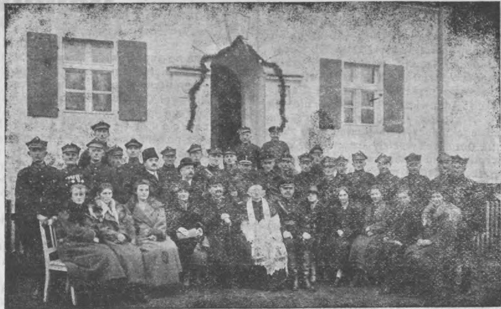
Poświęcenie domu dla placówki Straży Celnej w Skoroszech pow. Kępiński (Wielkopolska).
