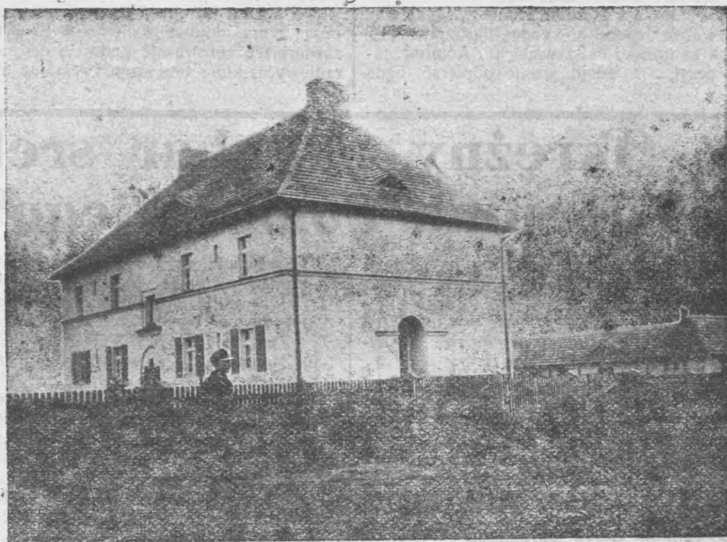
Budowa domów dla straży celnej
