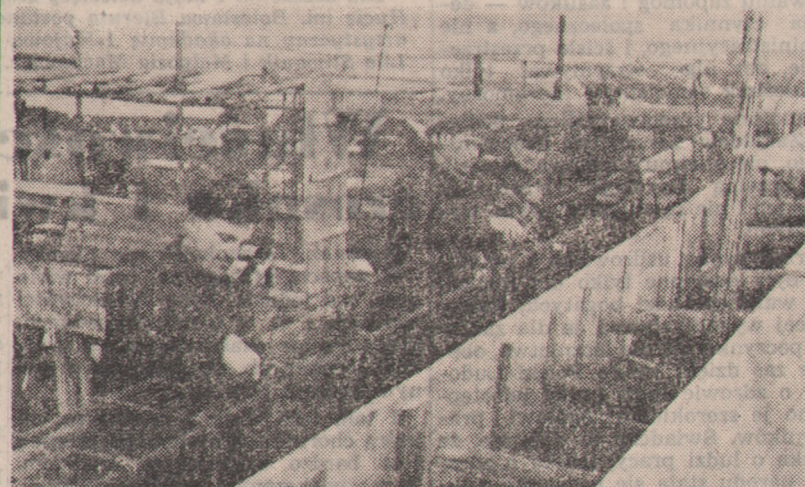
Brygada zbrojarska Władysława Gładysza należy do przodujących na budowie Kujawskich Zakładów Przemysłu Tłuszczowego w Kruszwicy. W pierwszym kwartale 1953 r. brygada wykonała 187 proc. planu kwartalnego.
