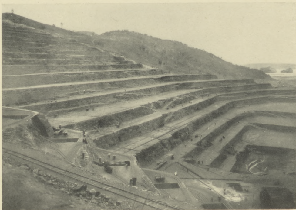
A. — HON-GAY (TONKIN), LES HOUILLÈRES. Exploitation à ciel ouvert, en gradins.
