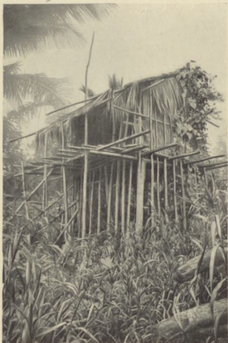
A. — MAISON SUR PILOTIS EN TERRE FERME. Région de la Lorentz-rivier, dans la Nouvelle- Guinée hollandaise. — Matières végétales : bois, clayonnage et herbes.
