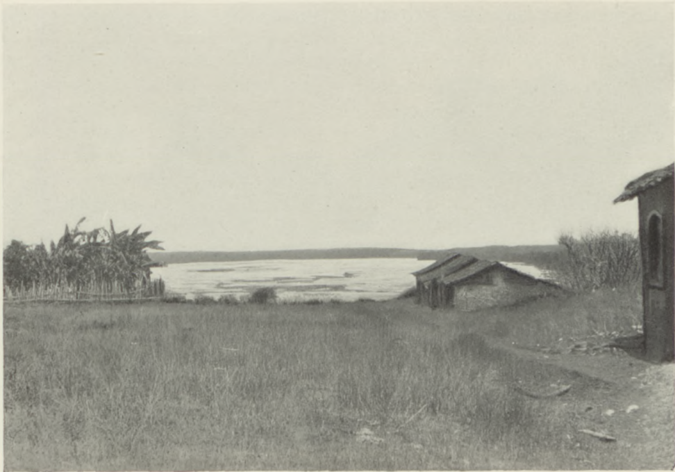
B. — LE RIO TOCANTINS VERS BÔA VISTA (GOYAZ).
