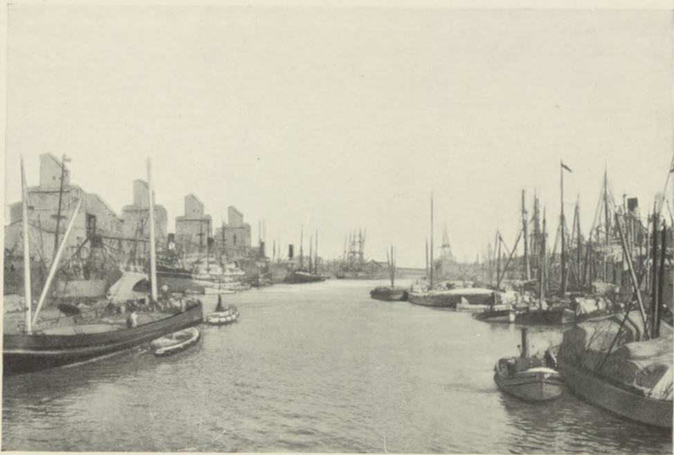
A. — PARTIE DU PORT DE BUENOS AIRES. ÉLÉVATEURS DE GRAINS. Construit de 1887 à 1898 sur le front Sud de la ville, le port comprend quatre bassins à écluses et deux grandes rades auxquelles on accède par des chenaux de 37 et de 8 kilomètres.
