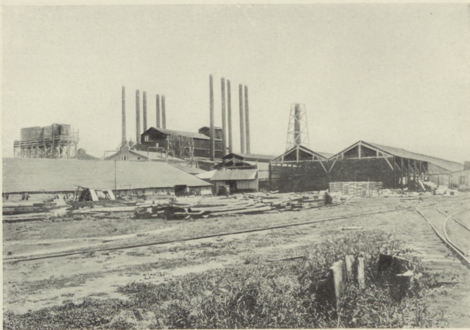
A. — USINE DE TANNIN, A PUERTO PINASCO (CHACO).
