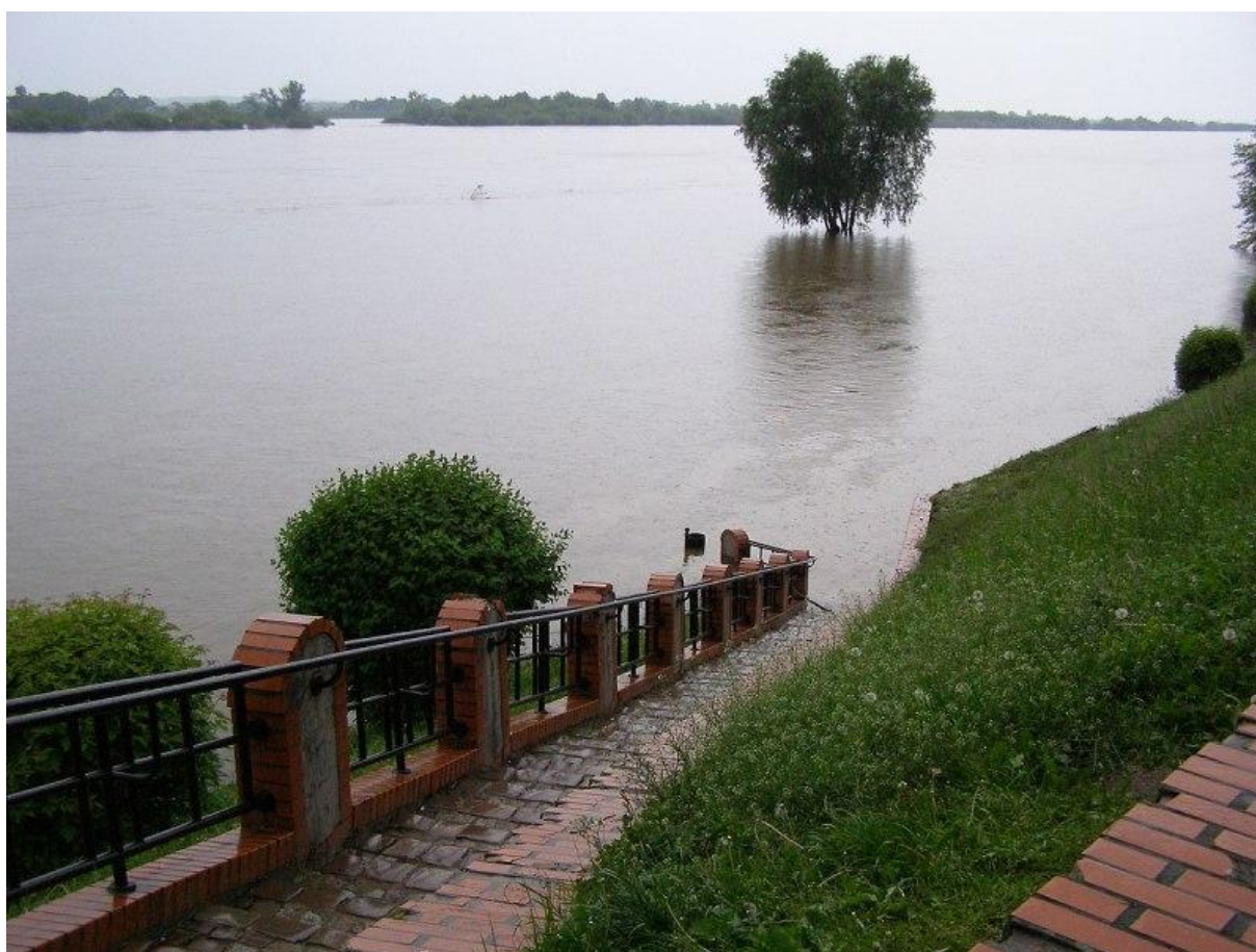
Bulwary nad Wisłą w Grudziądzu. Powódź 2010 r.
