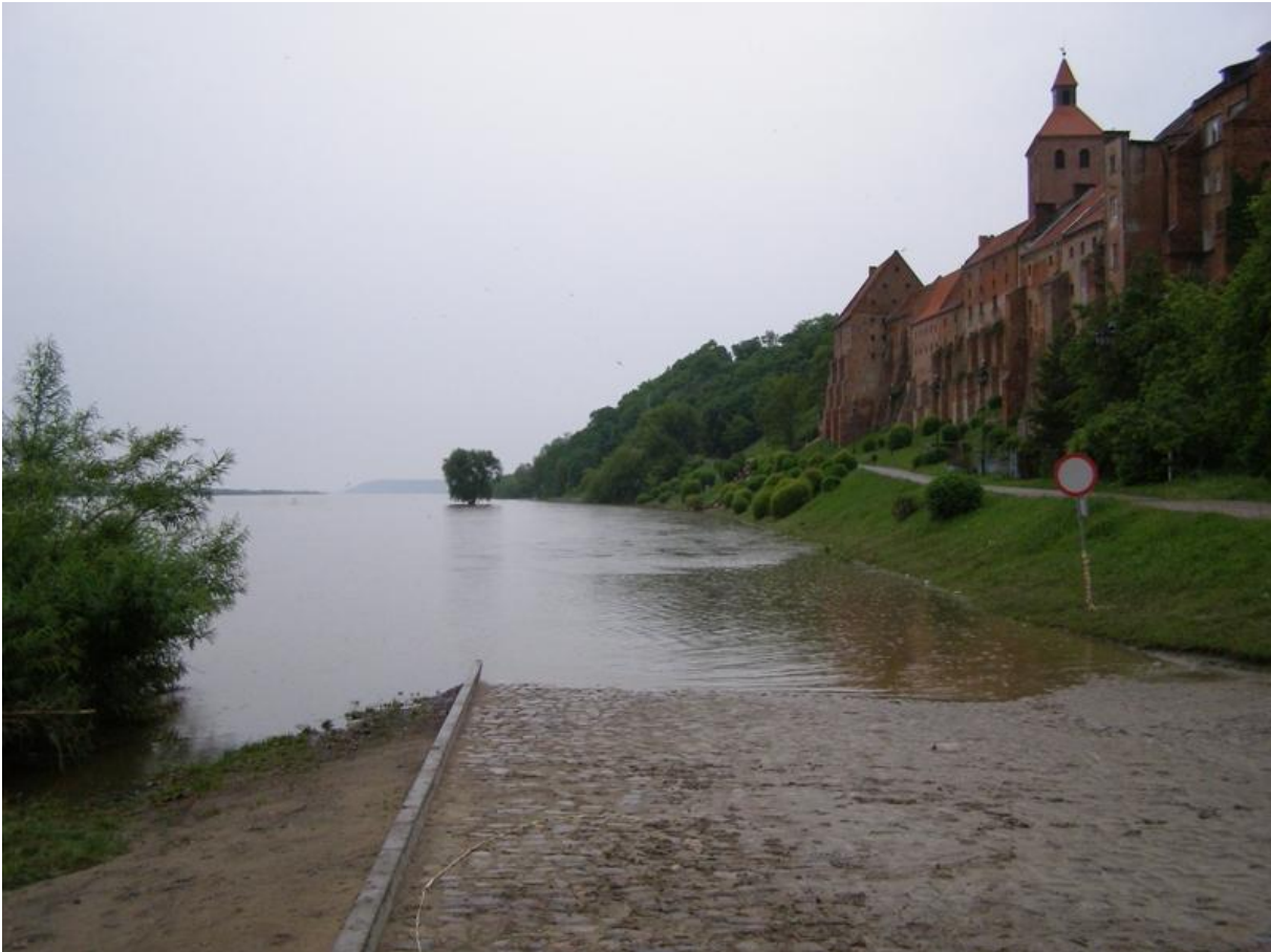
Bulwary nad Wisłą w Grudziądz. Powódź w 2010 r.
