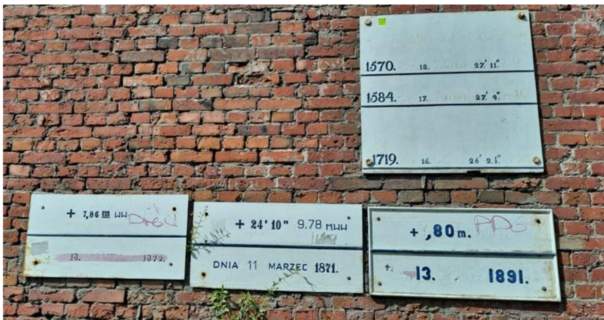
Tablice ze stanem wód Wisły na murze Hotelu Bulwar w Toruniu.
