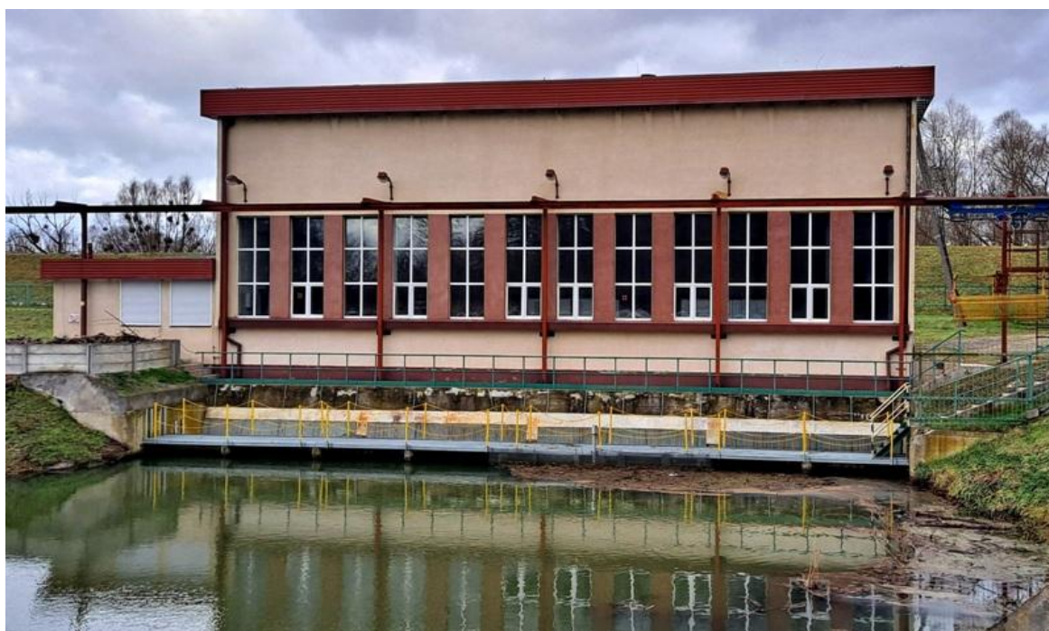
Nowa przepompownia na Rzędzu.
