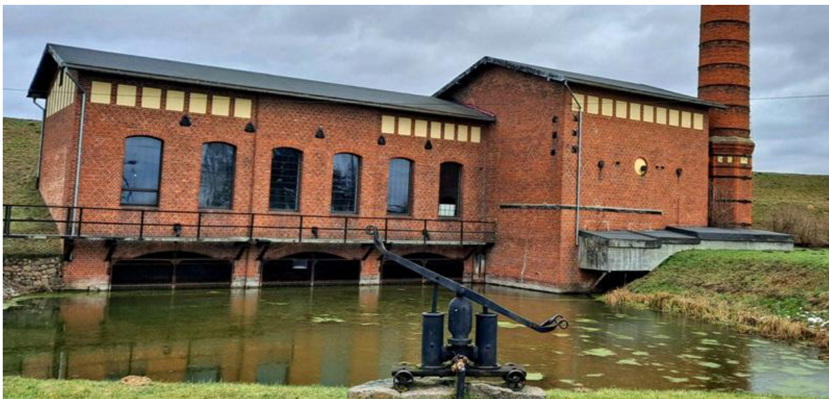
Stara przepompownia w Kończycach.
