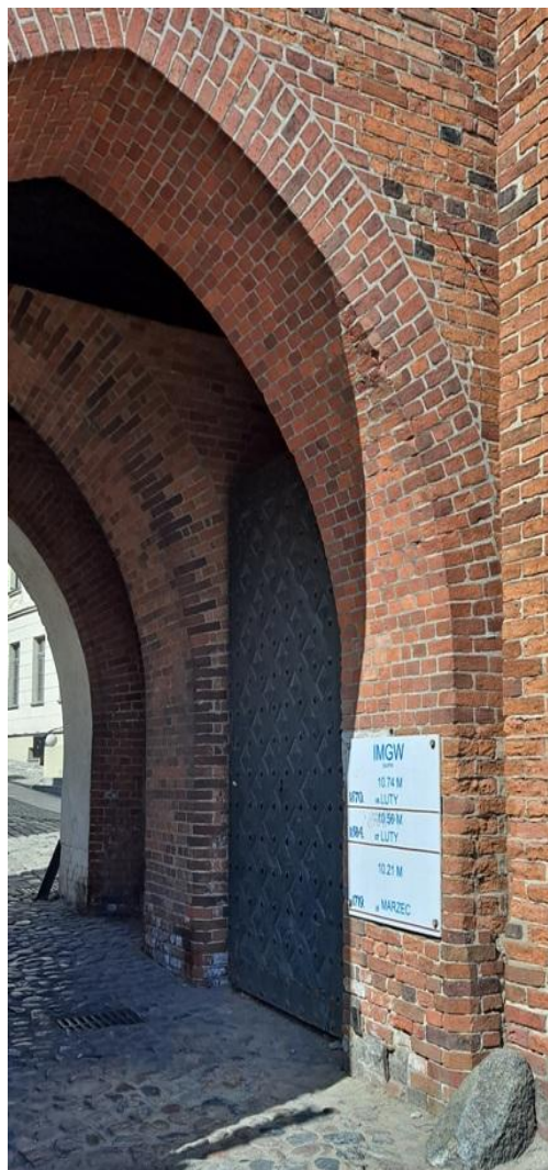
Tablice ze stanem wody na bramie w Toruniu.
