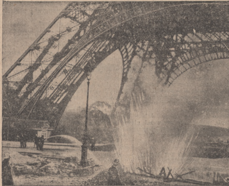
Straż pożarna przy gaszeniu pożaru, jaki wybuchł w pobliżu słynnej wieży Eiffla w Paryżu wskutek eksplozji gazów.
