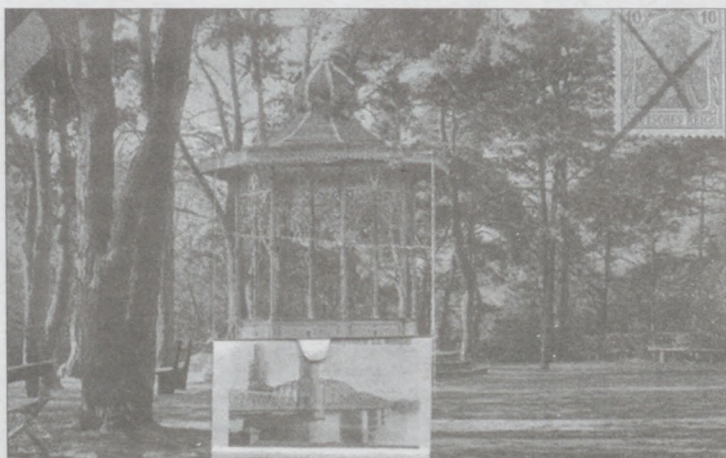
Ilustracja 168: Żelazna altana usytuowana na szczycie schodów prowadzących do Martówki (po 1900 roku)
