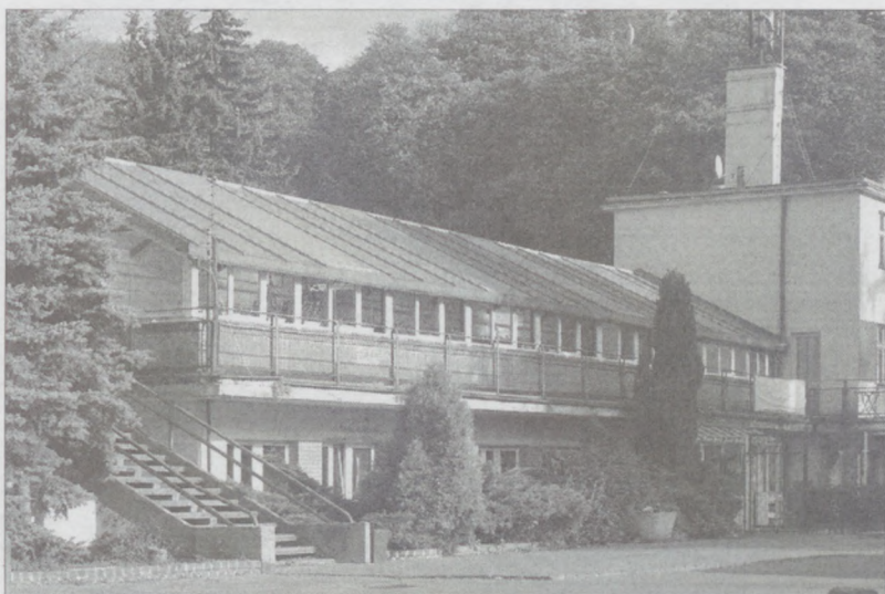
Ilustracja 78: Elewacja budynku administracyjnego Schroniska dla Zwierząt na ul. S. Przybyszewskiego
