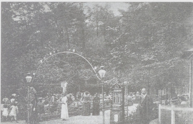
Ilustracja 54: Główna alejka parkowa vis-à-vis Restauracji „Cegielnia” prowadząca w kierunku pn.-zach. z widokiem fragmentu jednej z altanek ogrodowych (altanka z konarów brzozy) oraz „ogrodu restauracyjnego”
