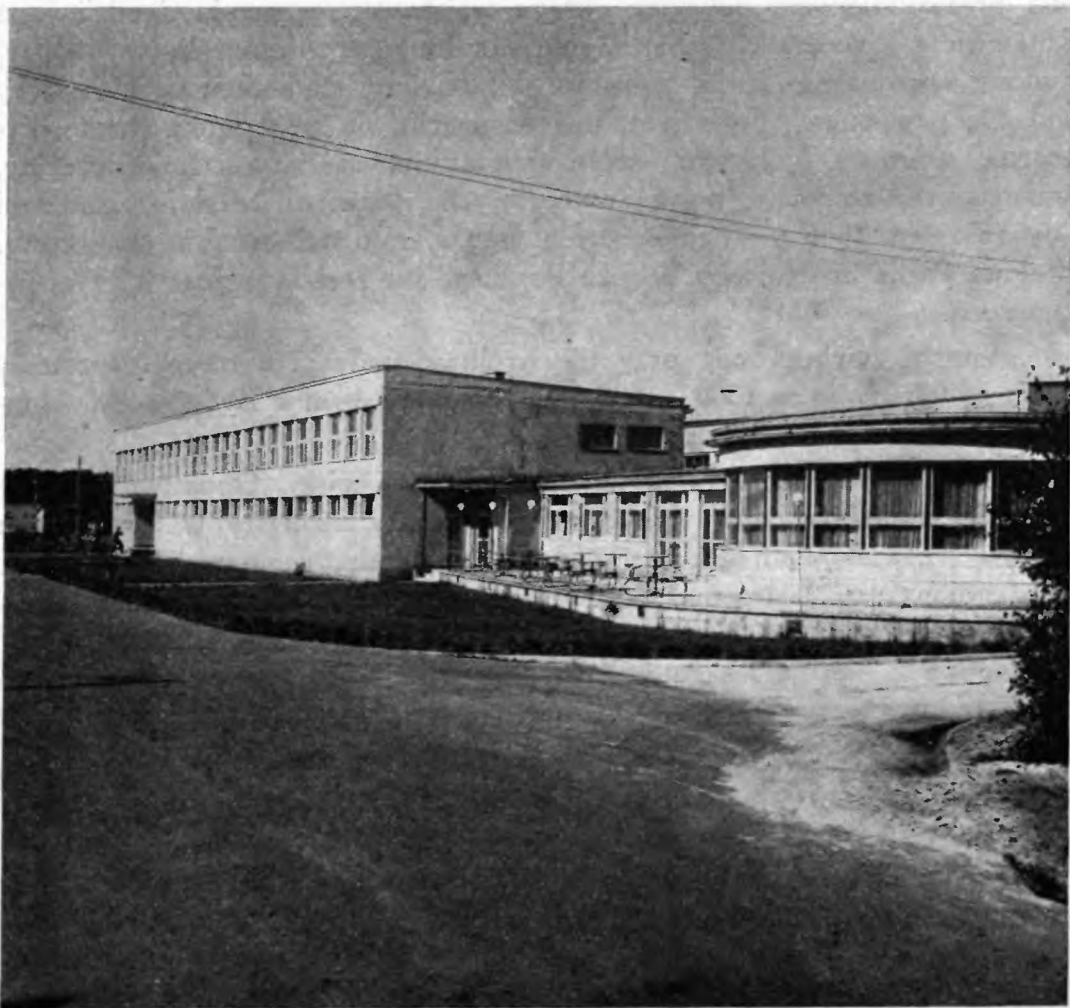
Park Sportowy Wojska Polskiego. Kompleks hal sportowych, pawilon administracyjny z zapleczem szatniowo-sanitarnym oraz kawiarenka klubowa. Fot. B. Woźniewski
